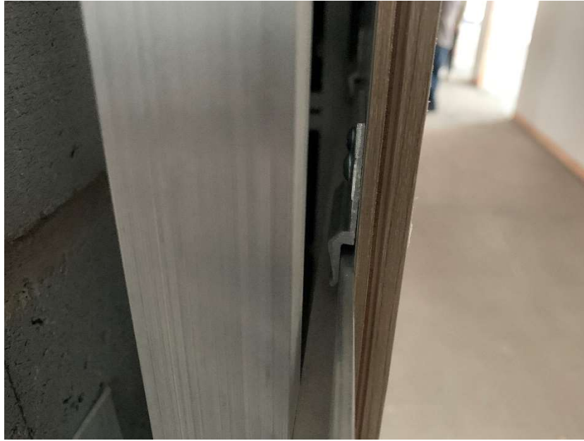
图 5.2.6.1 木饰面现场安装图
