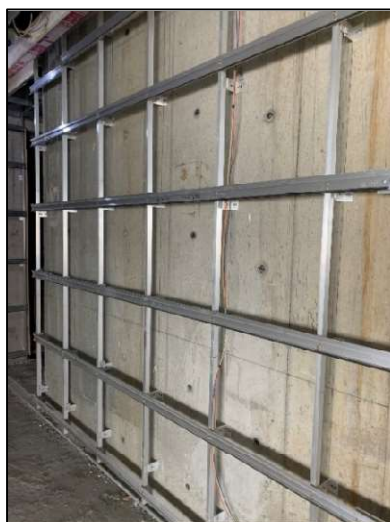
图 5.2.4-1 现场龙骨安装完成图
