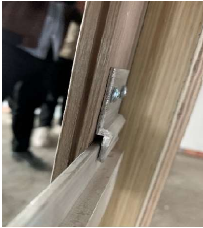
图 5.2.5 木饰面连接样板图
