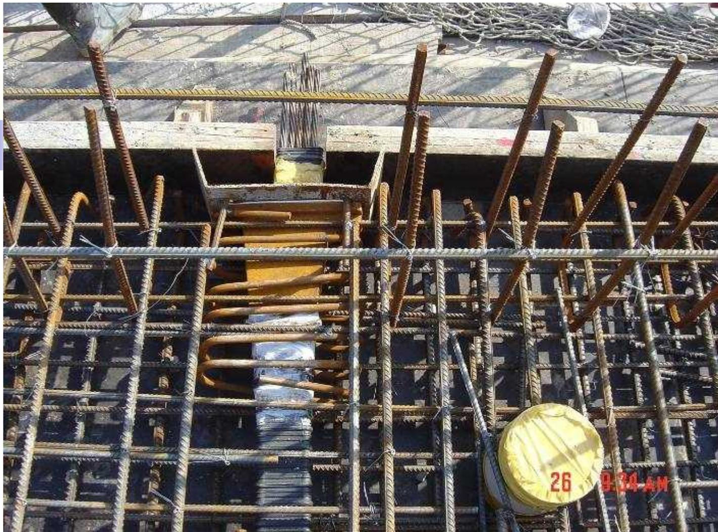
连续梁桥的桥面横向预应力钢束张拉端的安装，采用塑料扁波纹管留孔。
