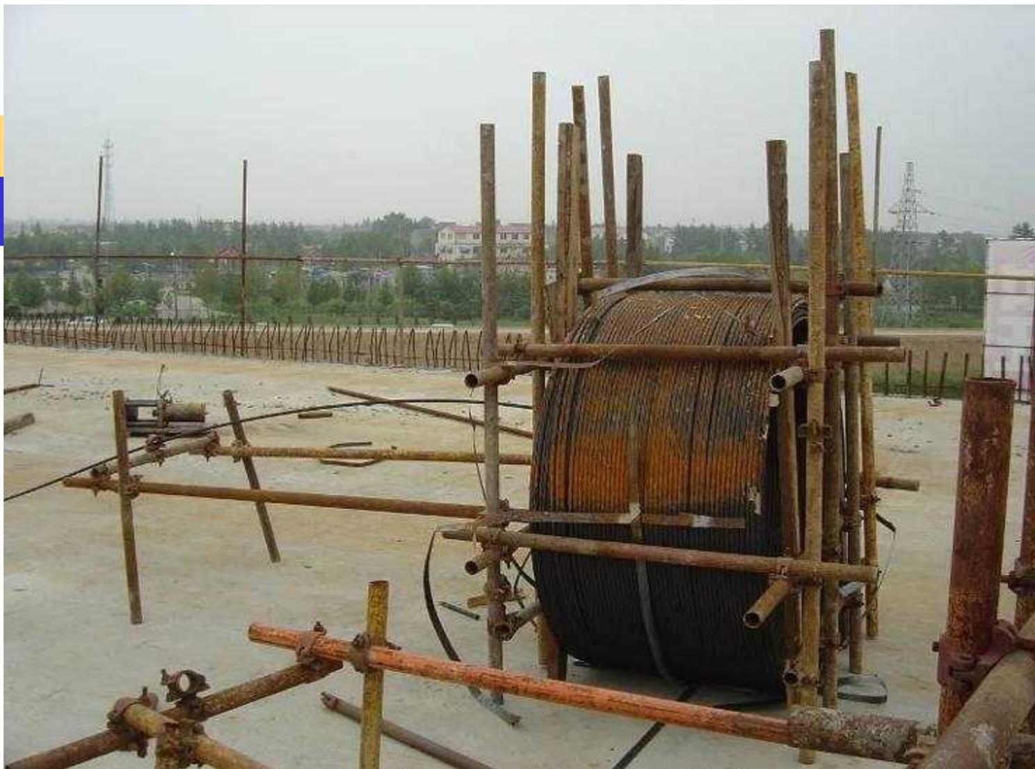
钢绞线一般成盘供货至施工现场。现场下料时，应用钢管和型钢架夹持钢绞线盘，以免开盘时钢绞线弹伤人。
