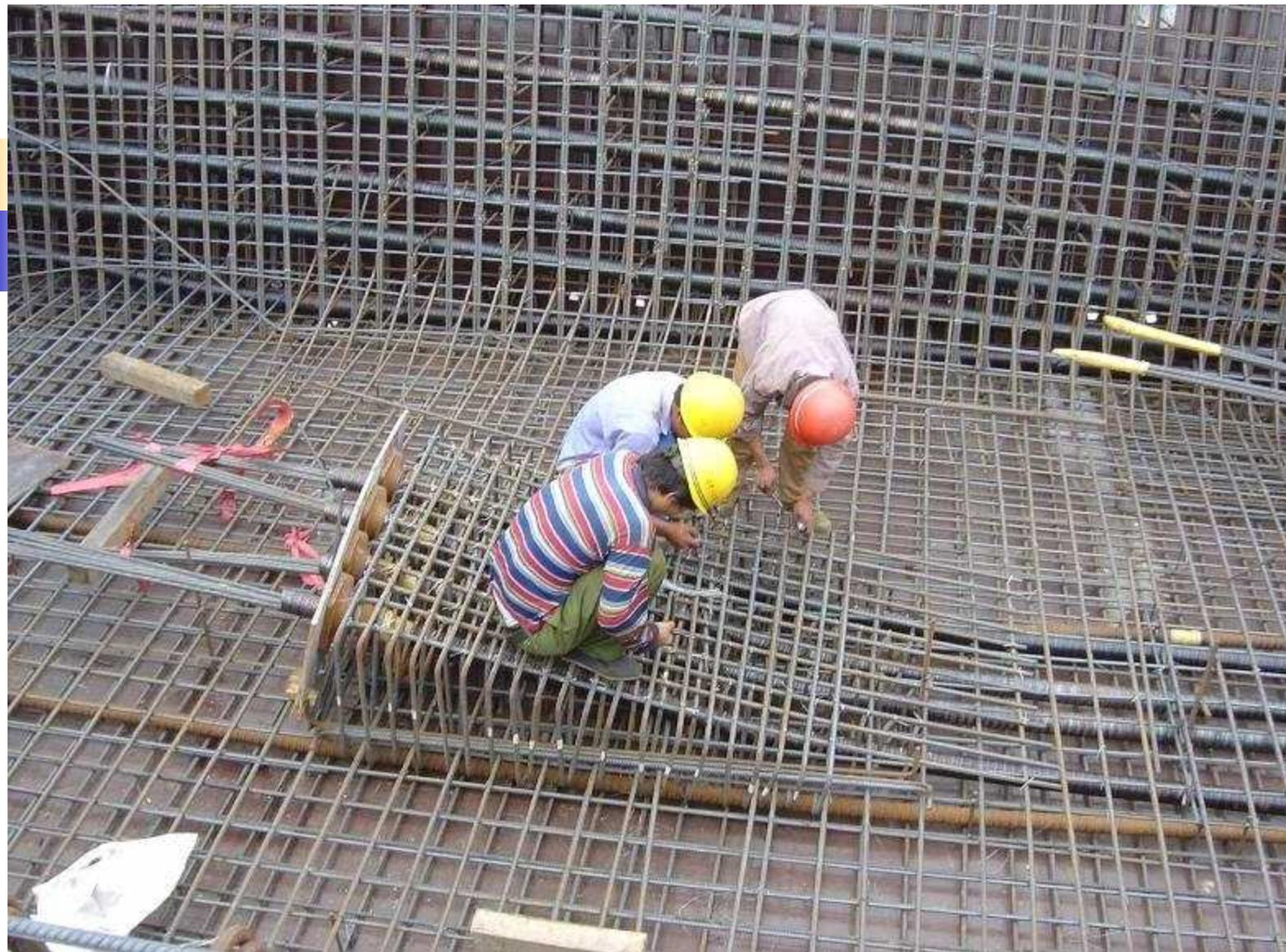
连续梁桥箱梁底板预应力钢束在齿板处的安装。
