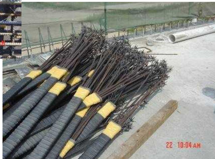
连续梁桥的桥面横向预应力钢束固定端采用钢绞线压花锚的安装。
