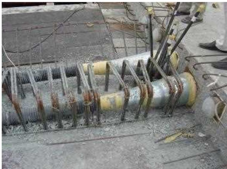
桥梁逐跨浇筑逐跨张拉，在跨与跨接缝处预应力钢筋锚具和连接器的安装。
